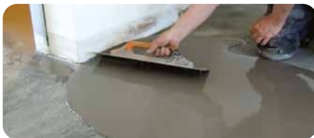
Poravnavanje novih betonskih podnih ploča na sustavu za konsolidaciju podnih ploča.
