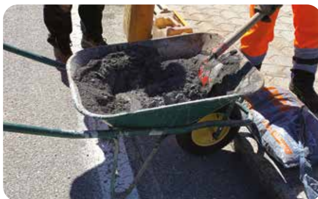
2B. Ručna priprema smjese betonroad.
