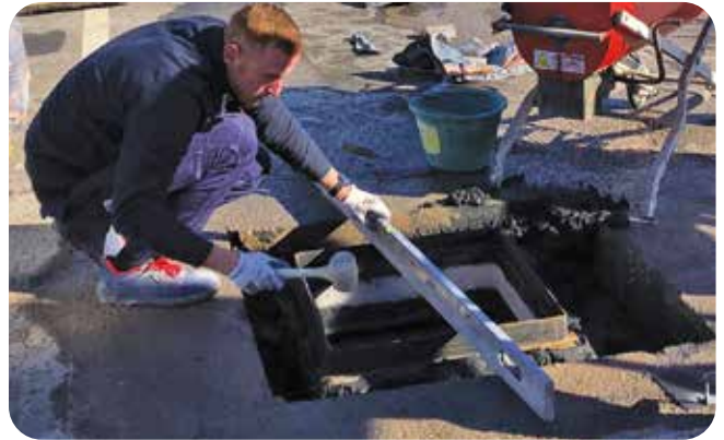
4. Postavljanje okvira i izravnavanje s visinom ceste.
