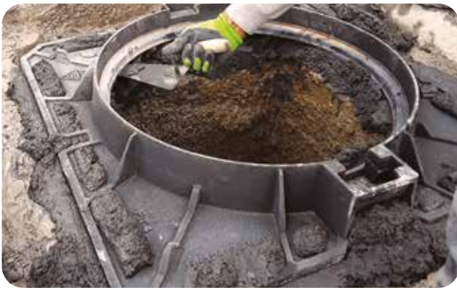
5. Unutarnje ojačanje tiksotropnom smjesom betonroad.
