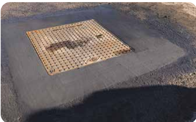
8. Postavljanje poklopca i puštanje ponovno u promet.
