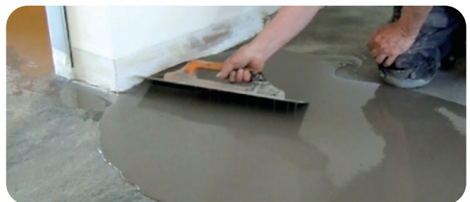
Poravnavanje novih betonskih podnih ploča na sustavu za konsolidaciju podnih ploča.
