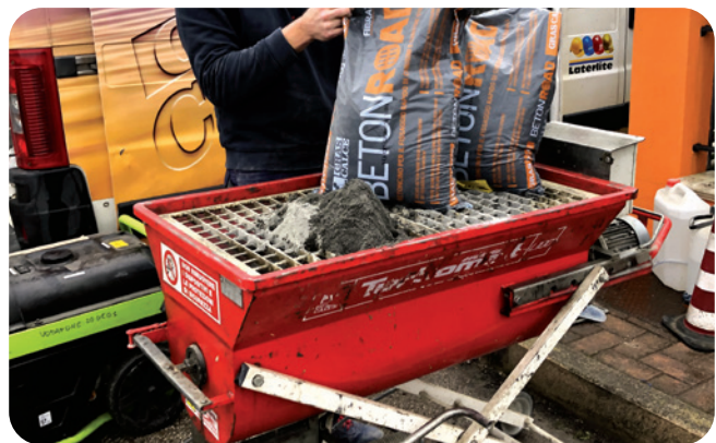
2A. Priprema smjese betonroad spiralnom miješalicom.
