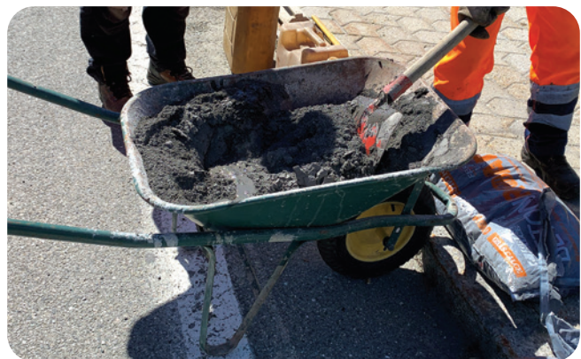
2B. Ručna priprema smjese betonroad.
