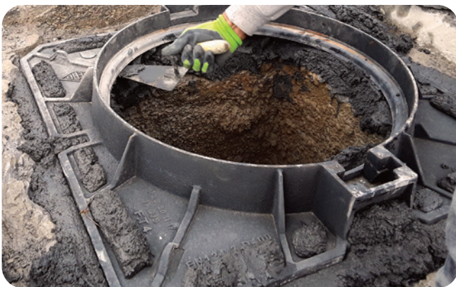
5. Unutarnje ojačanje tiksotropnom smjesom betonroad.
