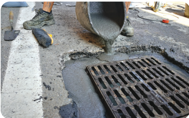
6b. Vanjska ispunjena tekućom smjesom betonroad.
