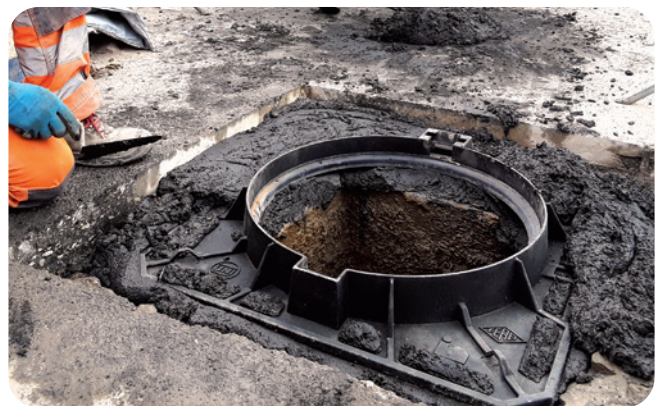
6a. Vanjska ispunjena tiksotropnom smjesom betonroad.
